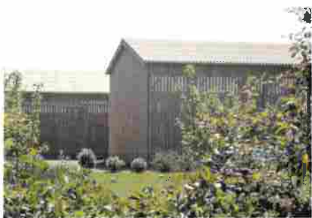
Exemple de bardage en bois qualitatif avec plantation de haie de différentes strates et à distances variées (source : Bâtiments agricoles et paysage, CAUE de Loire-Atlantique)
