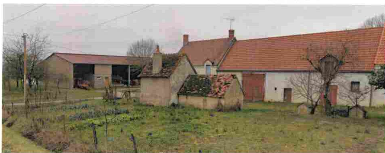
_ Exemple de hangar agricole s'insérant dans le tissu bâti alentour
