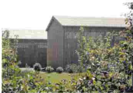
Exemple de bardage en bois qualitatif avec plantation de mix de différentes strates et à distances variées (source : Bâtiment agricoles et paysage, CAUT de Loire-Atlantique)
