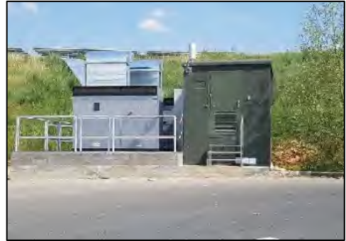
Figure 5 : Poste de transformation (Crédit photo : SERGIES, 2017)
