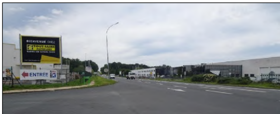
Figure 86 : Photographie de la zone industrielle de Buzançais (Source : NCA Environnement)
