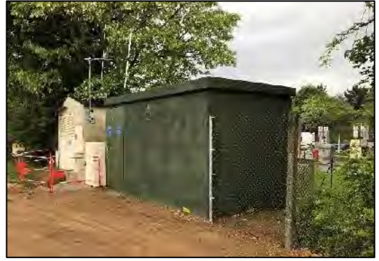
Figure 7 : Poste de livraison (Crédit photo : SERGIES, 2015)
