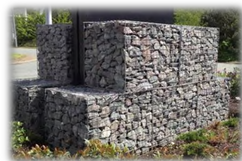
Figure 20 : Exemple de muret en gabion
