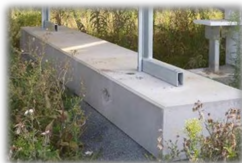
Figure 19 : Types de fondation - semelle béton
