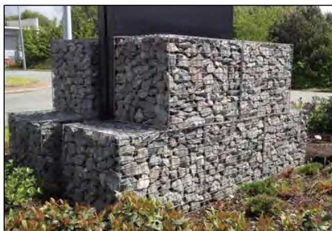
Figure 4: Exemple de muret en gabion
