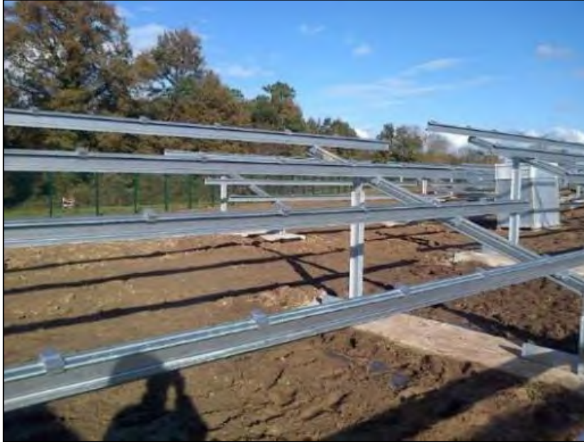
Figure 24 : Exemple de chantier de construction – Pose des structures
