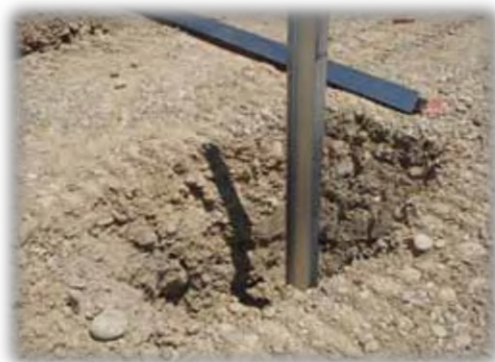
Figure 18 : Types de fondation - pieux battus
