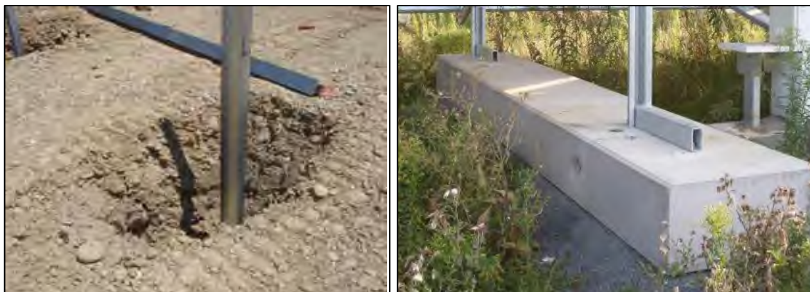
Figure 3 : Types de fondation - pieux battus (gauche) et semelle béton (droite)
