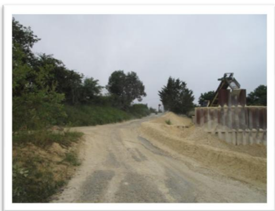
Photo 15 : Vue sur la voie d'accès au site empruntée par les camions de transport
