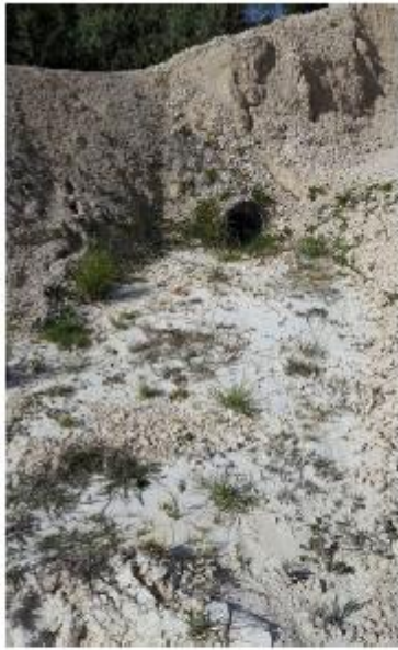
Drainage des eaux de ruissellement juste avant l'arrivée sur le bassin de décantation
