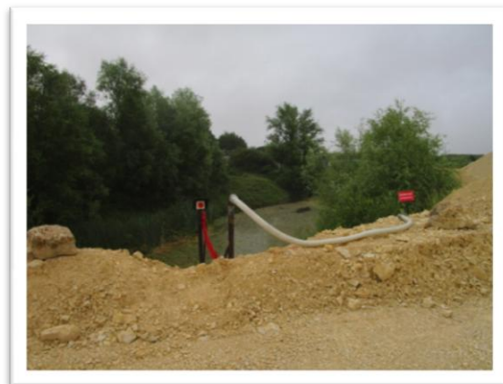
Photo 23 : Vue sur le point d'aspiration d'eau au droit du bassin de rétention infiltration
