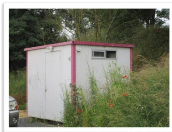
Photo 31 : Vue sur le bungalow vestiaires-sanitaires
