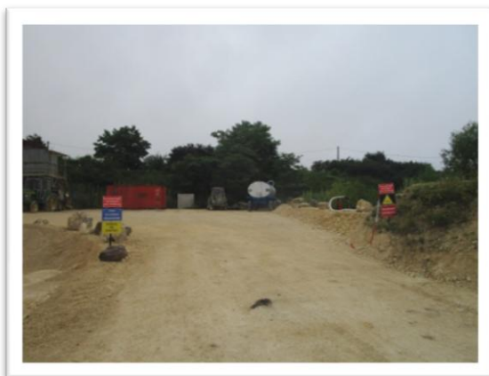
Photo 24 : Vue sur les panneaux signalant les dangers en entrée de l'installation de traitement des matériaux
