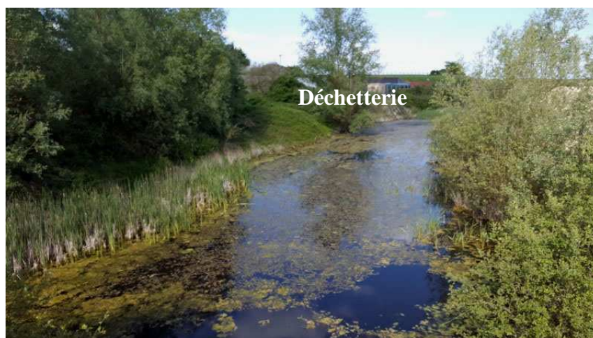
Vue sur le bassin du Sud vers le Nord
