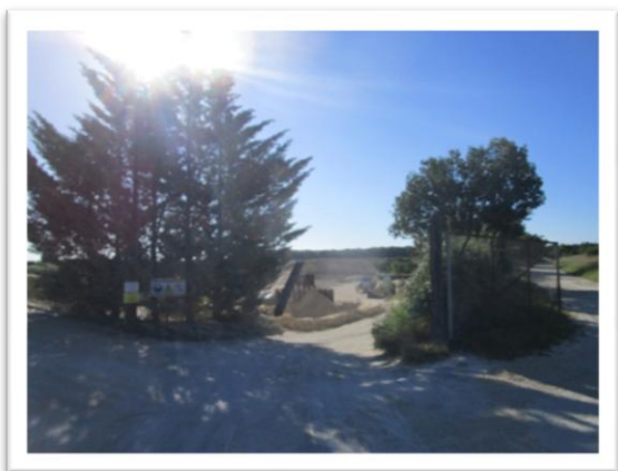
Photo 25 : Vue sur l'entrée du site et les panneaux de signalisation des dangers
