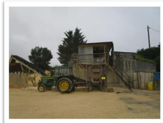
Photo 5 : Vue sur l'installation de traitement actuelle
